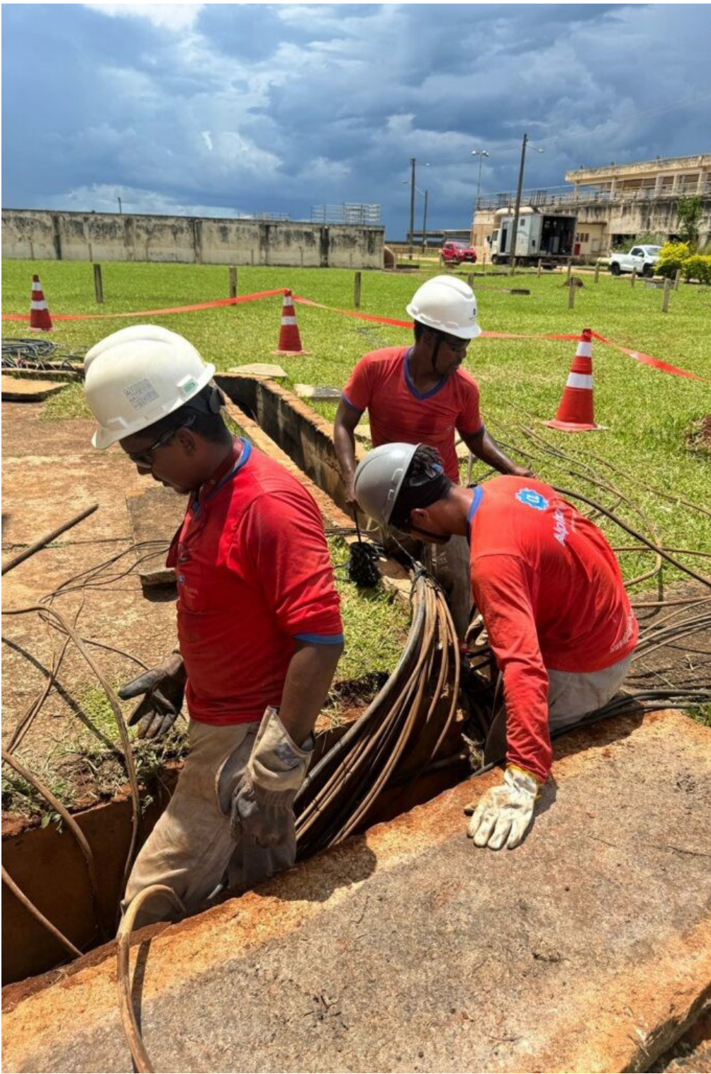
Troca de cabos de energia elétrica para recuperar a ETA - Foto: Divulgação
