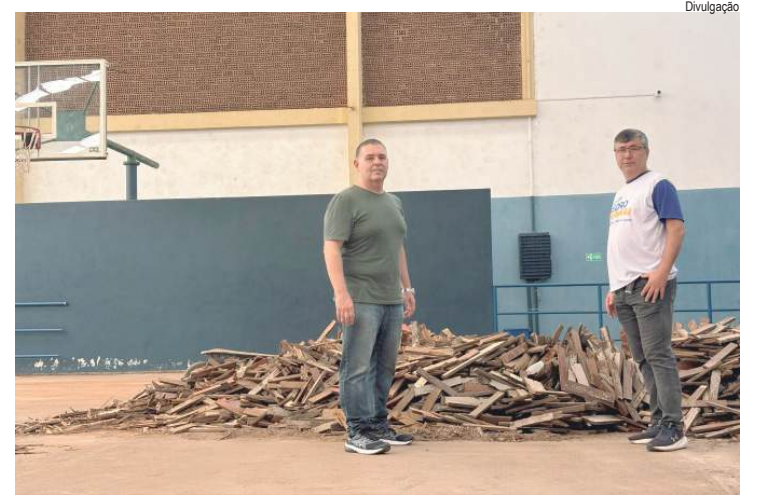
Pedro Kawai acompanhou, na manhã desta segunda-feira, o andamento das obras de manutenção no Ginásio Municipal de Esportes da Vila Rezende "Felício Maluf"
