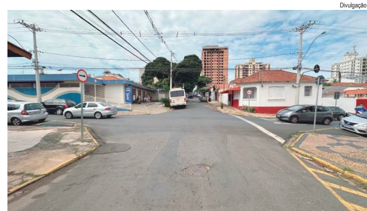
Recapeamento asfáltico compreende trecho entre as ruas Floriano Peixoto e Dom Pedro I
