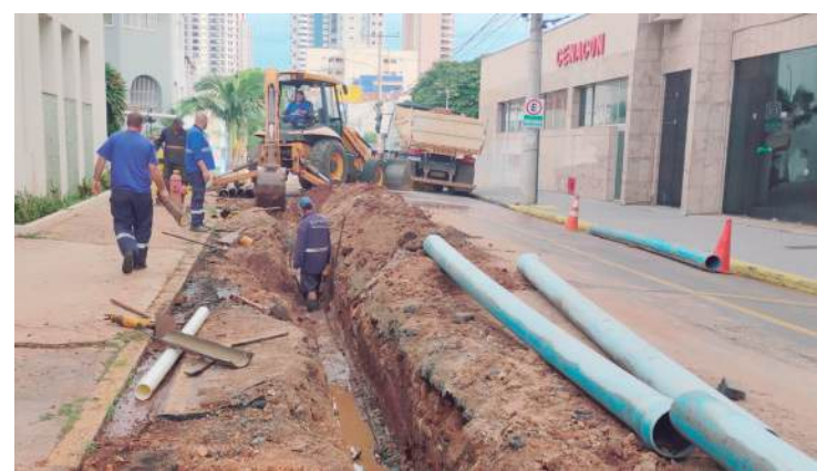
Servidores do Sema realizou a troca de 70 metros de rede de água na região central nesta segunda-feira (11)
